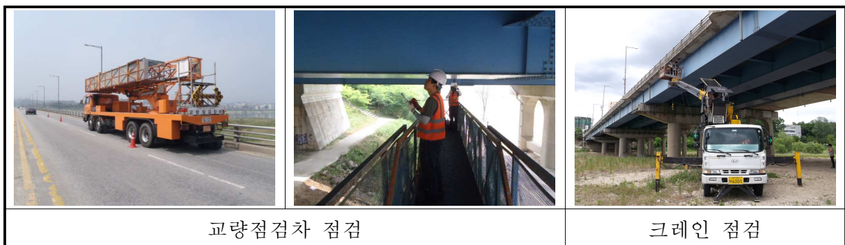
<그림 2.1.1> 외관조사 전경
